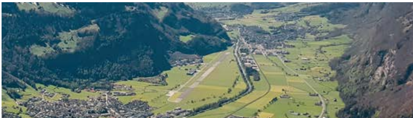
Vom Flugplatz Mollis, idyllisch eingebettet in die Glarner Berge, können diverse Gebirgslandeplätze bereits nach kurzer Flugzeit erreicht werden.
